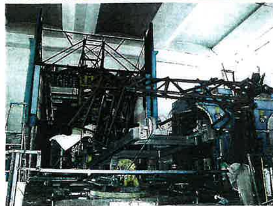
Sono iniziati i lavori per realizzare le strutture portanti dei carri
