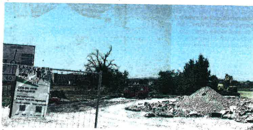
Sono iniziati i lavori per realizzare il nuovo parco Rio Rigoncello
