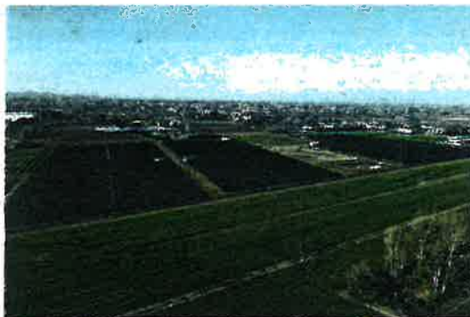
L'ex area rottamazione dove sono stati posti pannelli fotovoltaici
